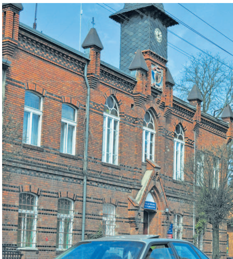
Po termomodernizacji ratusz ma zachować zabytkową, ceglana elewację
