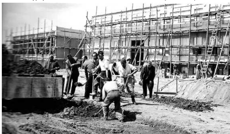
„Trójka” w budowie
