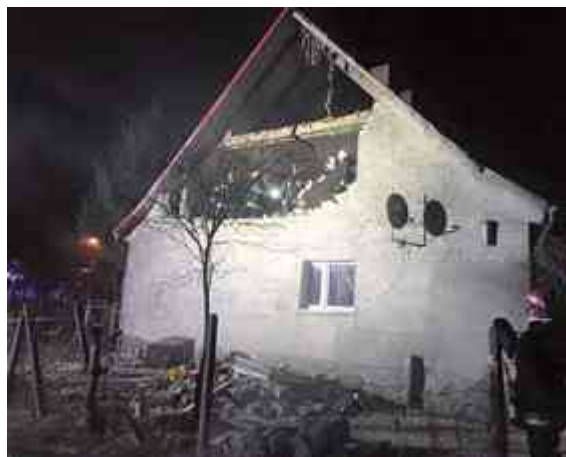
Strażacy musieli wyburzyć uszkodzony fragment ściany
