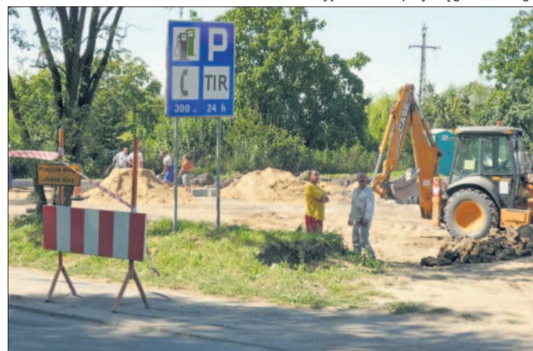
Budowa parkingu przy cmentarzu w Wąbrzeźnie
