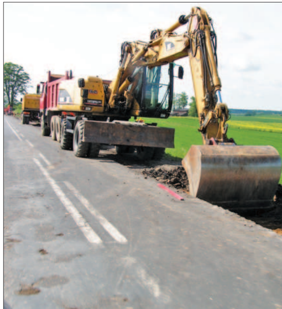
Remont drogi nr 534, z Grudziądza do Rypina, przebiegającej przez Wąbrzeźno
