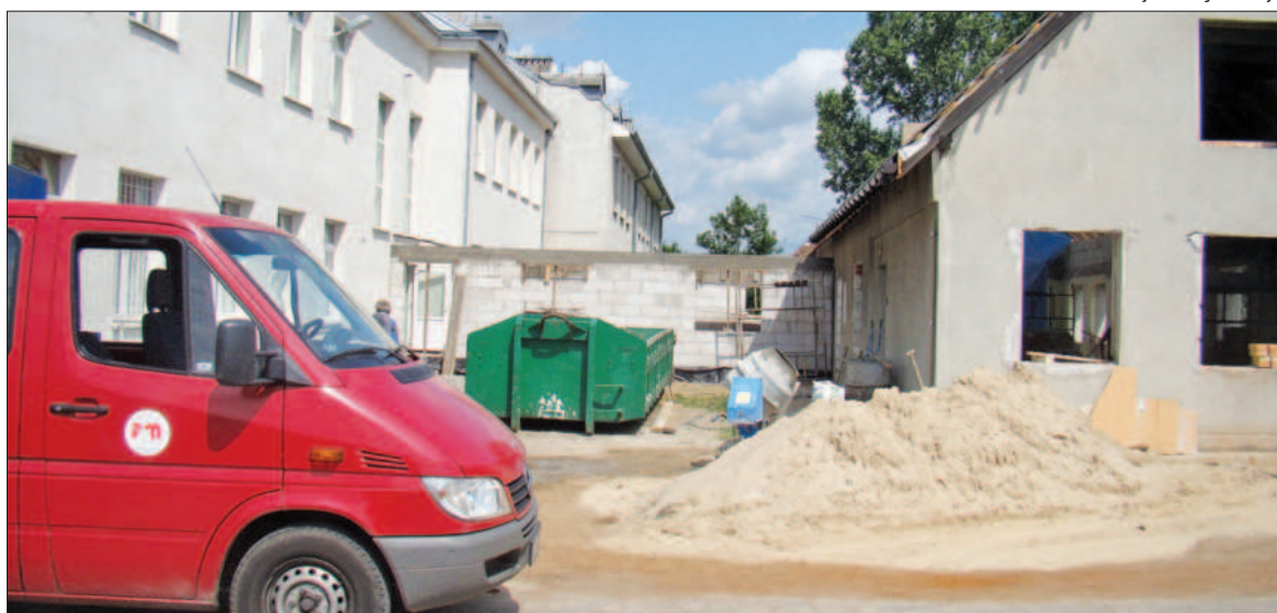
Remont szkoły w Płużnicy
