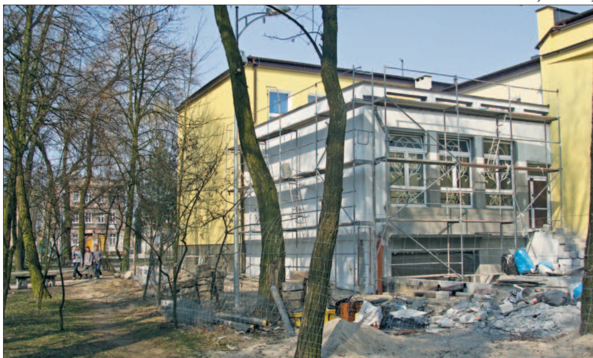
Rozbudowa Domu Kultury
