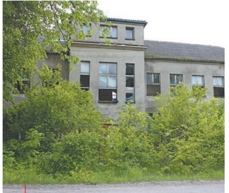
Budynek straszy powybijanymi szybami
