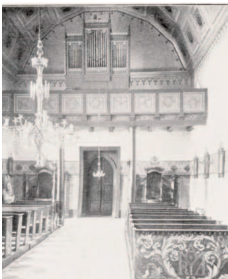
Wnętrze kościoła w Nowej Wsi Królewskiej
