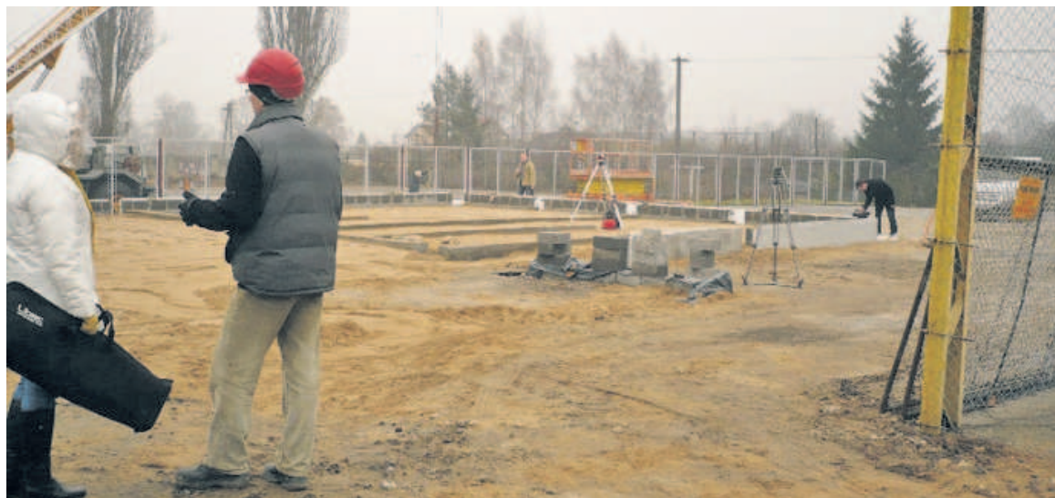
Prace już trwają
