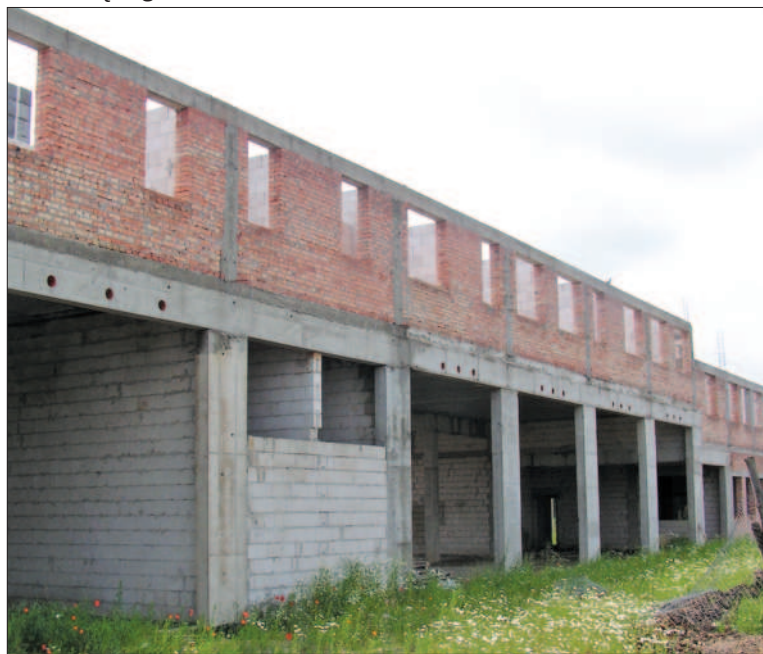
W tym roku strażnica ma zostać pokryta dachem
