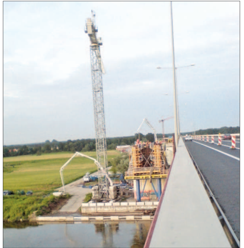
Budowa mostu autostradowego w Grabowcu pod Toruniem. Do pracy tu potrzeba wielu specjalistów
