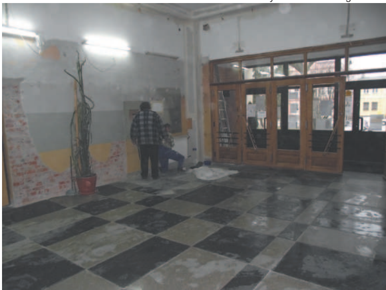
Obecnie w WDK remontowany jest hol
