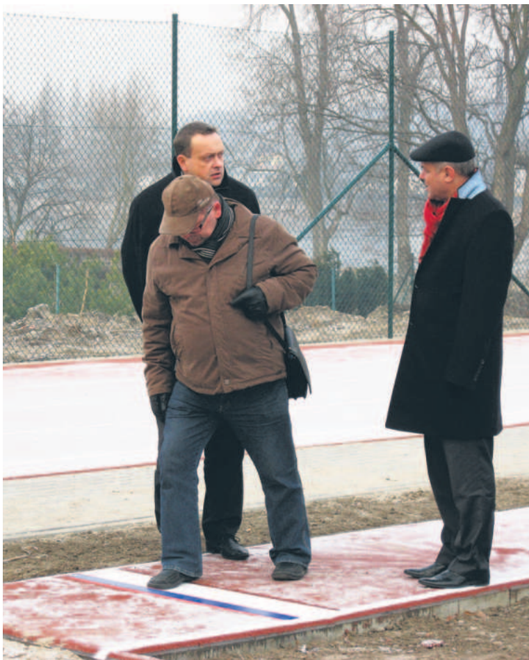
Odbiór techniczny boiska odbył się w grudniu, w sobotę zostanie ono oficjalnie otwarte
