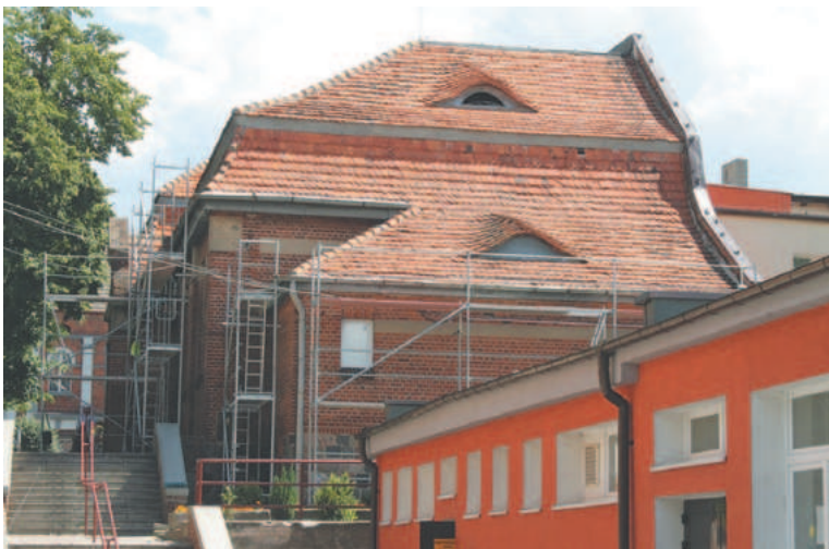
Ruszył remont dachu na budynku sali gimnastycznej Szkoły Podstawowej nr 2
