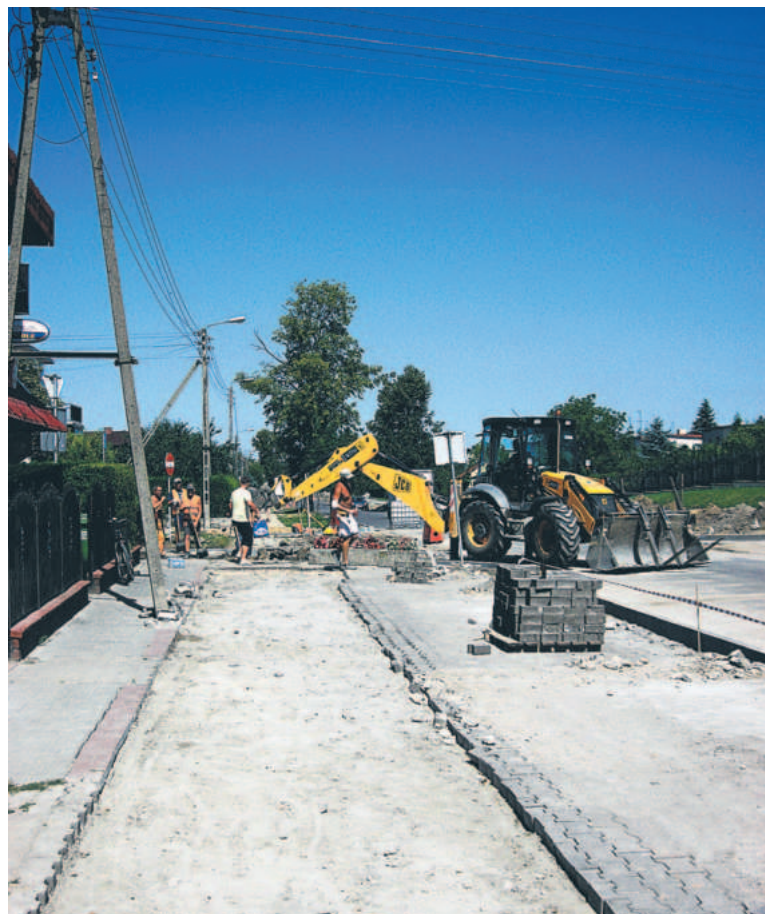
Na ul. Grudziądzkiej prace jeszcze trwają, zostały do zrobienia m.in. chodniki
