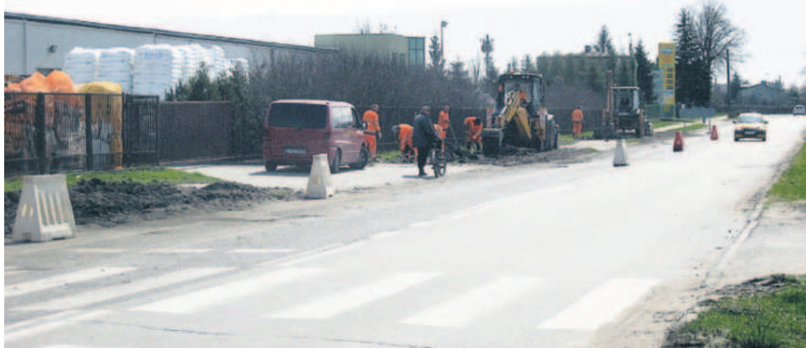
17 kwietnia rozpoczął się remont ulicy Kętrzyńskiego
