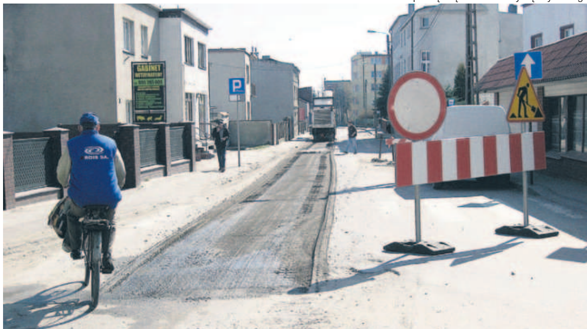
Obecnie ul. Partyzanta jest zamknięta od skrzyżowania z ul. 1 Maja do ulicy Mickiewicza
