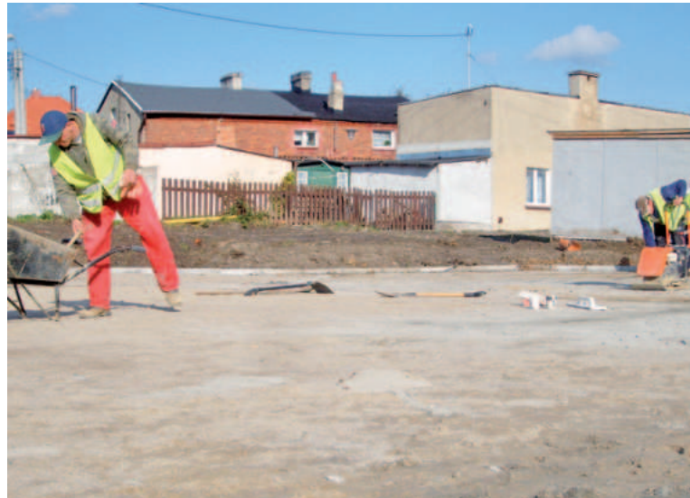
Wśród prac, które wykonali pracownicy interwencyjni wymienić można m.in. budowę parkingu przy cmentarzu
