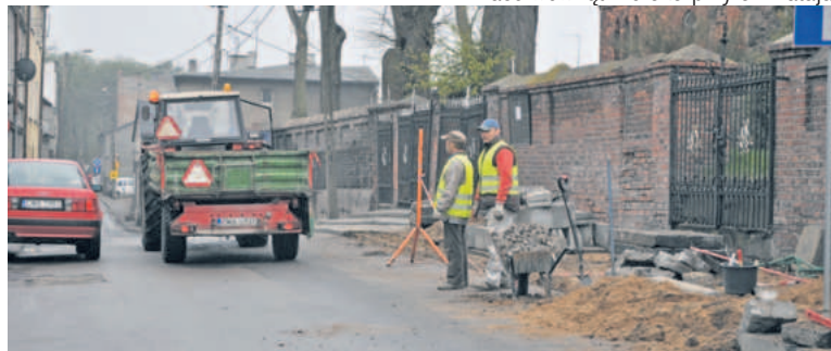
Prace przy chodniku na ul. Górnej
