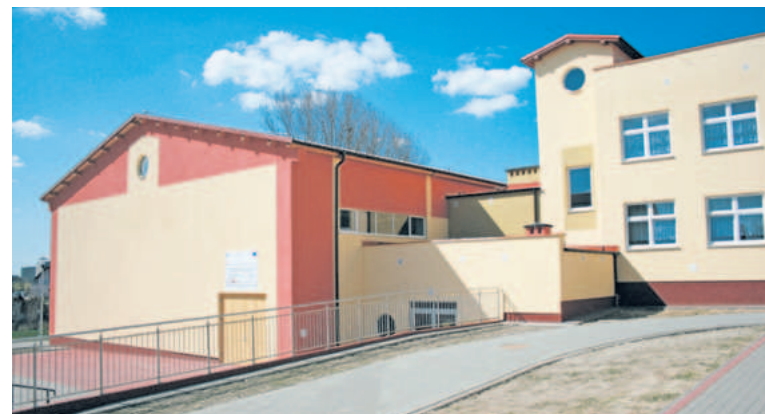
Nowe skrzydło budynku ZSZ przy ul. Żeromskiego
