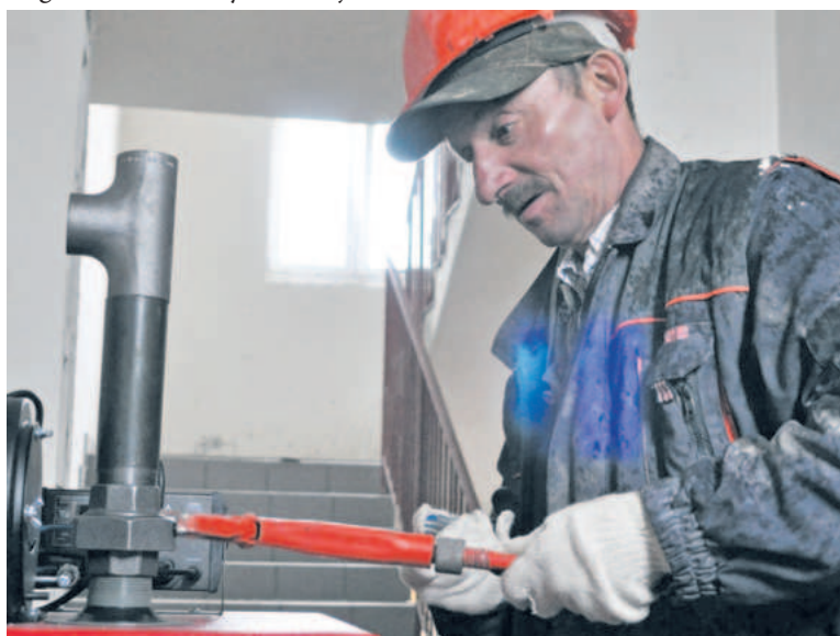
Prace wewnątrz bloku przy ul. Rataja
