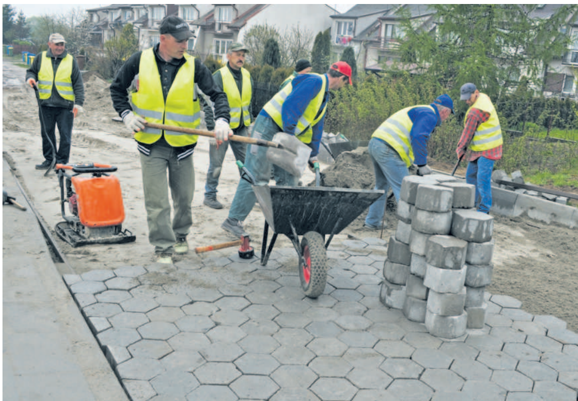
Układanie kostki na ul. Cisowej
