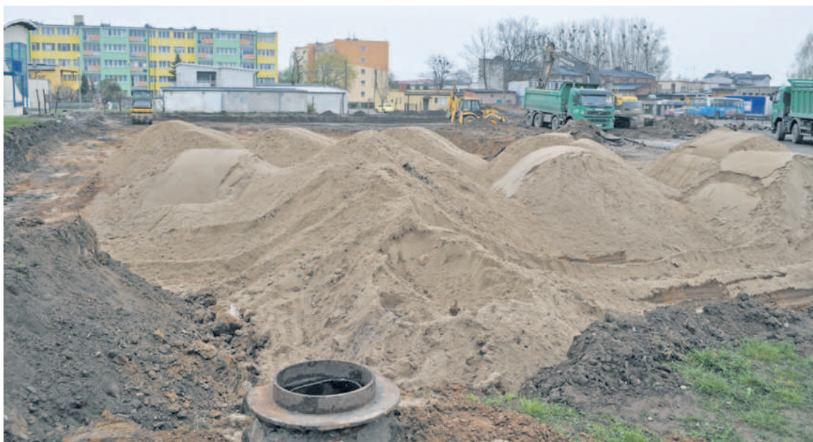
Zaczęły się prace przy Orliku
