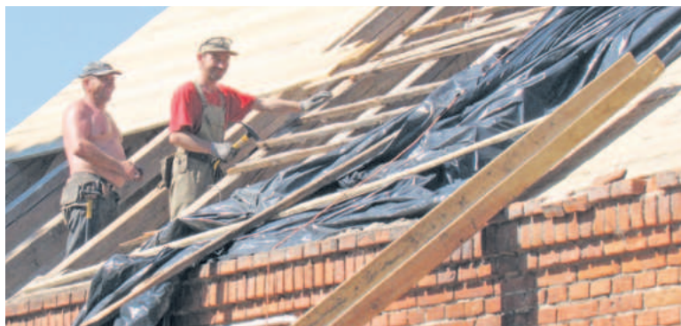
Wykorzystując dobrą pogodę robotnicy zajmują się remontem dachu
