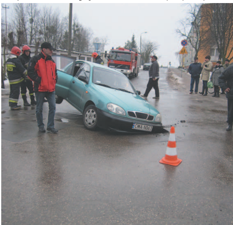
Ulica Matejki jest już w tak kiepskim stanie, że na początku lutego awaria wodociągu spowodowała zapadnięcie się jezdni pod przejeżdżającym samochodem
