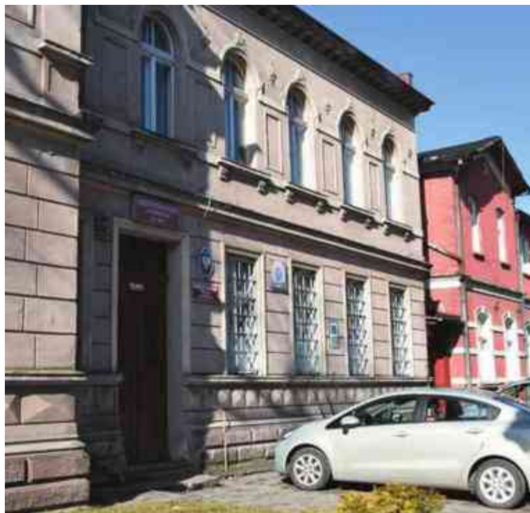
Budynek przy ul. Wolności zostanie całkowicie wyremontowany
