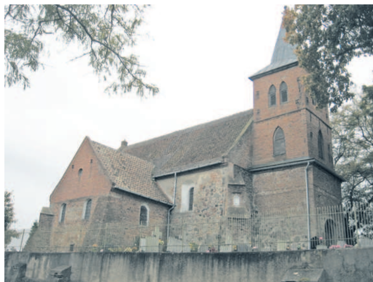
Gotycka budowla pochodzi prawdopodobnie z XIV w.
