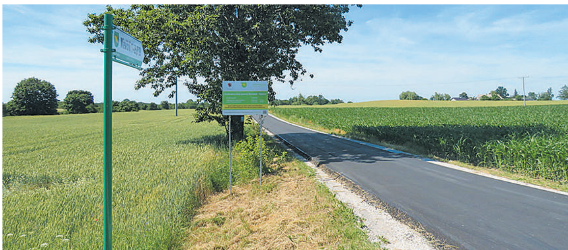
Na drodze gminnej w Wiewiórkach wykonano odcinek próbny
