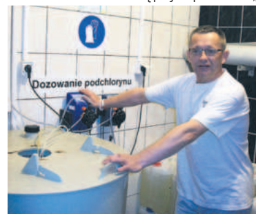
Urządzenie dozujące chlor i kwas, które dezynfekują wodę w nieckach dzieci obejrzały ze względów bezpieczeństwa z daleka
