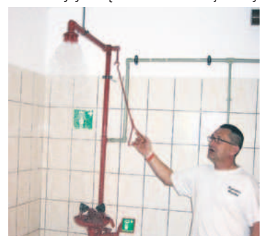
Prysznic, pod którym pracownik, który oblałby się substancjami chemicznymi mógłby się szybko umyć
