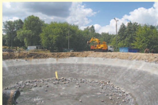
Ruszyła modernizacja wąbrzeskiej oczyszczalni ścieków
