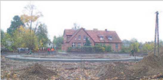
Ruszyła przebudowa kilometrowego odcinka drogi wojewódzkiej nr 548 w Dębowej Łące
