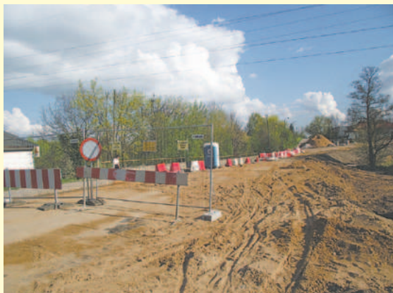
Ruszyła budowa drogi na Kowalewo
