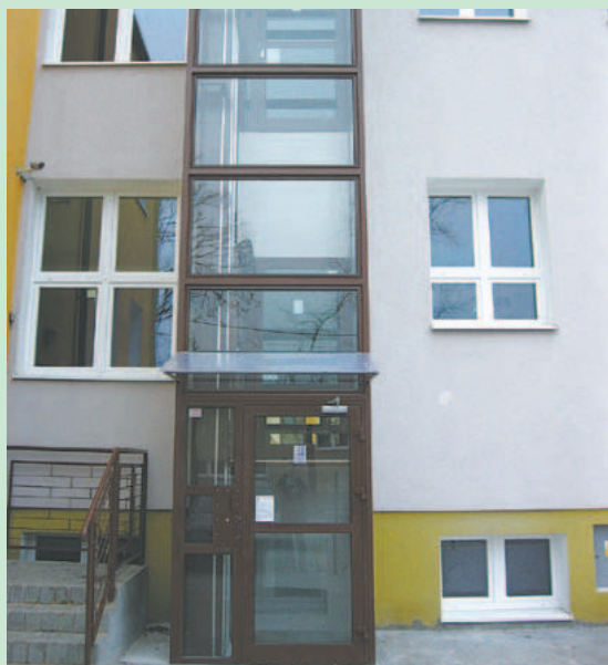
W Szkole Podstawowej nr 3 w Wąbrzeźnie zainstalowano windę zewnętrzną dla osób niepełnosprawnych
