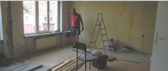
Rozstrzygnięto głosowanie na budżet obywatelski. Wygrały projekty: remont i modernizacja strażnicy OSP, odtworzenie harcówki i wykonanie przystani na Jeziorze Zamkowym
