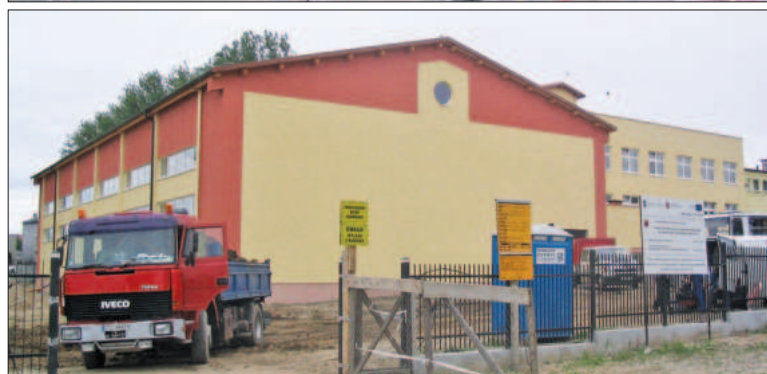
Budowa sali gimnastycznej ma zakończyć się w grudniu tego roku
