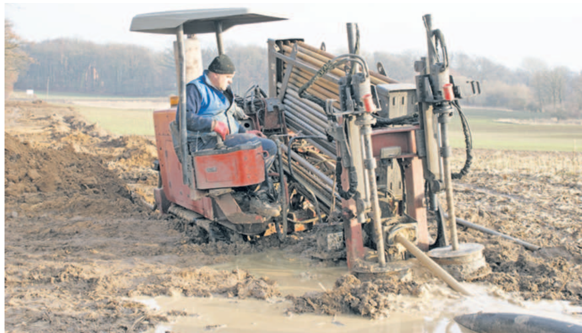
Prace związane z budową kanalizacji na odcinku Niedźwiedź – Dębowa Łąka
