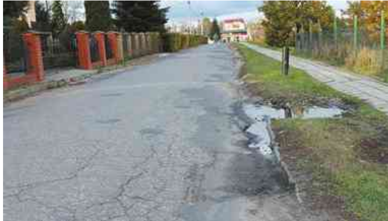
ul. 750-lecia Wąbrzeźna zostanie całkowicie przebudowana
