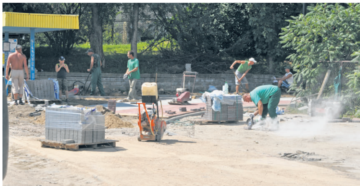
Ostatnie prace przy układaniu kostki
