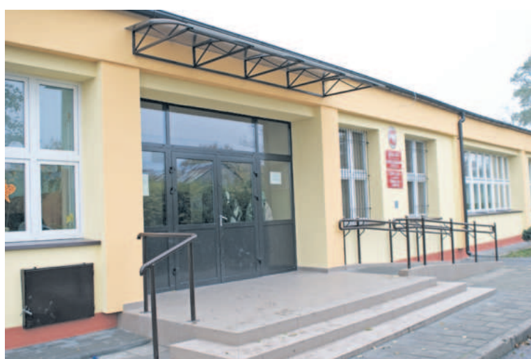
Wejście do szkoły po przeprowadzeniu prac
