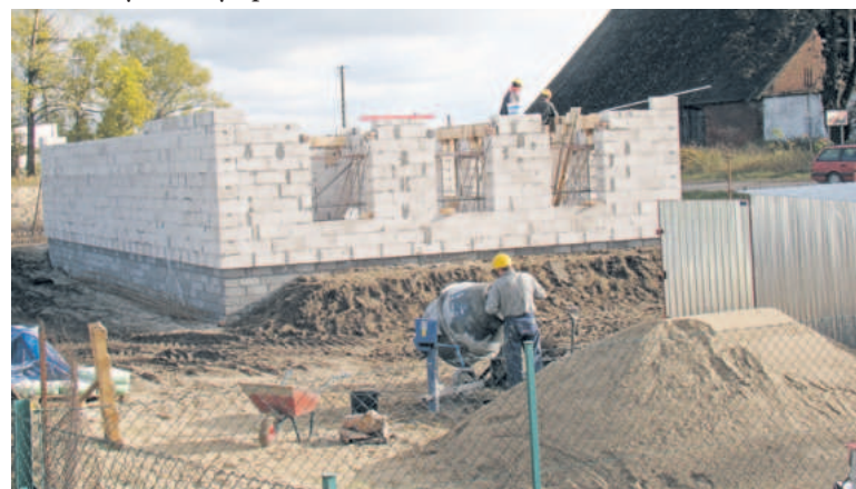
Prace w Nielubiu wykonuje firma z Grudziądza. Bryła nowej świetlicy rośnie w oczach
