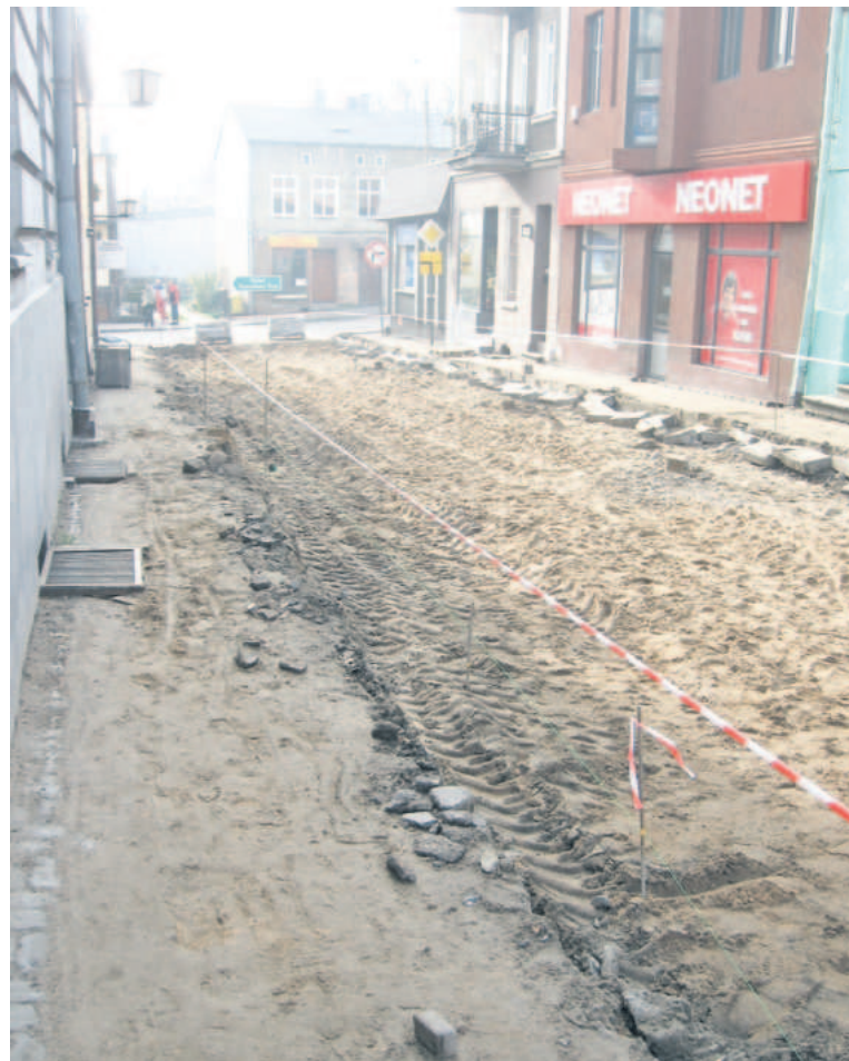
Choć umowy jeszcze nie podpisane, prace już trwają
