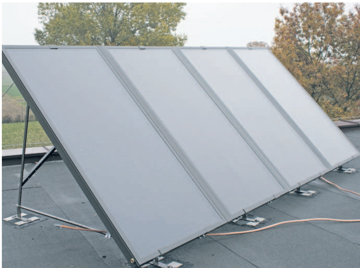
Płaski kolektor słoneczny od góry jest pokryty specjalną szybą, która ma zatrzymywać promieniowanie w kolektorze i w ten sposób zmniejszać straty na skutek odbicia promieni
