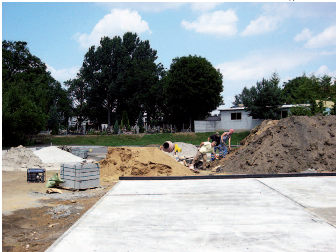
Przy szkole w Książkach trwa budowa boiska wielofunkcyjnego (fot. PG)
