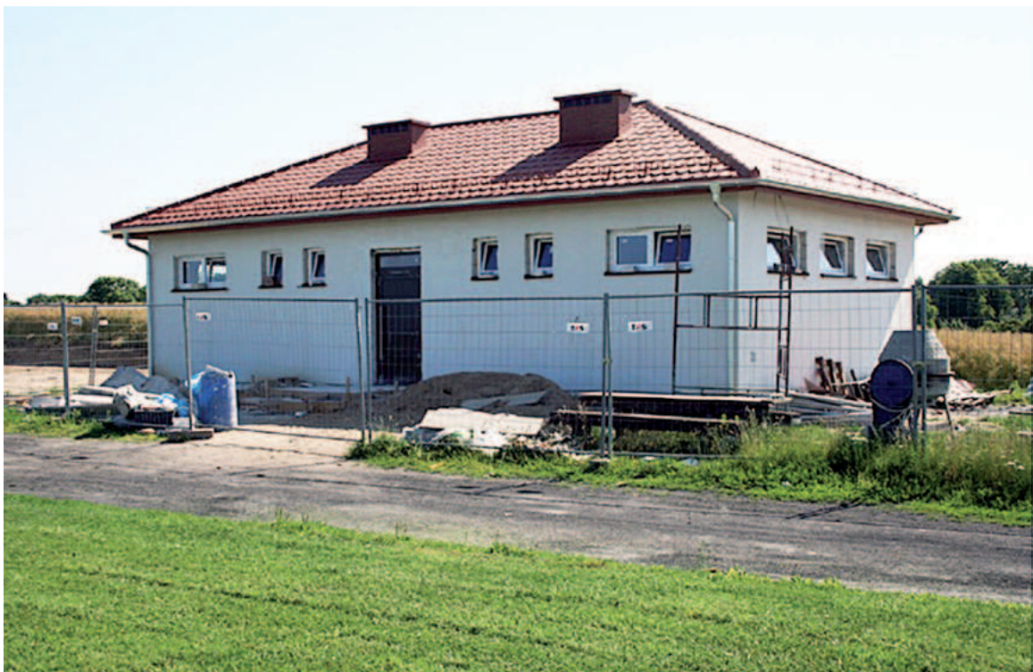
Trwa budowa budynku sanitarno-szatniowego w Ryńsku
