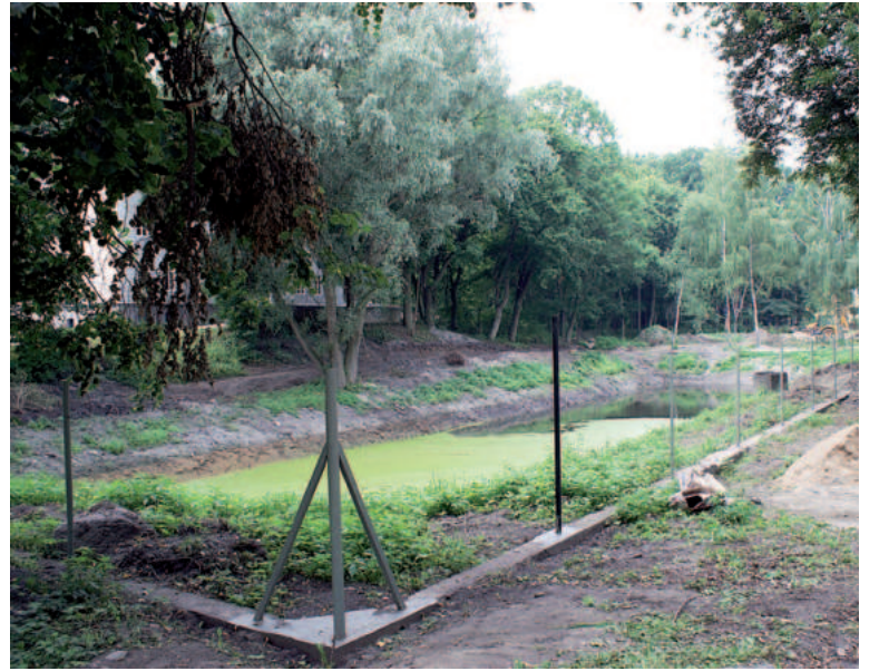
Trwa remont zbiornika przeciwpożarowego w Dębowej Łące
