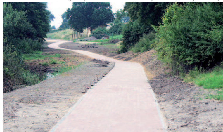
Dobiegają końca prace związane z zagospodarowaniem terenu nad jeziorem w Wielkądzu. Na plażę przy remizie będzie można dojść wybudowaną nad jeziorem ścieżką pieszo-rowerową
