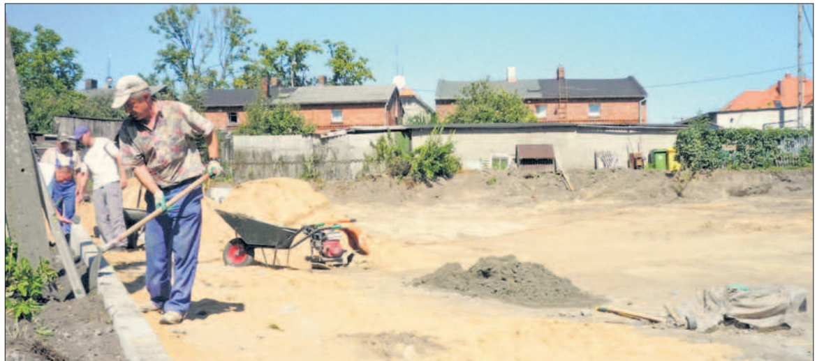
Budowa parkingu to także miejsce pracy dla robotników interwencyjnych
