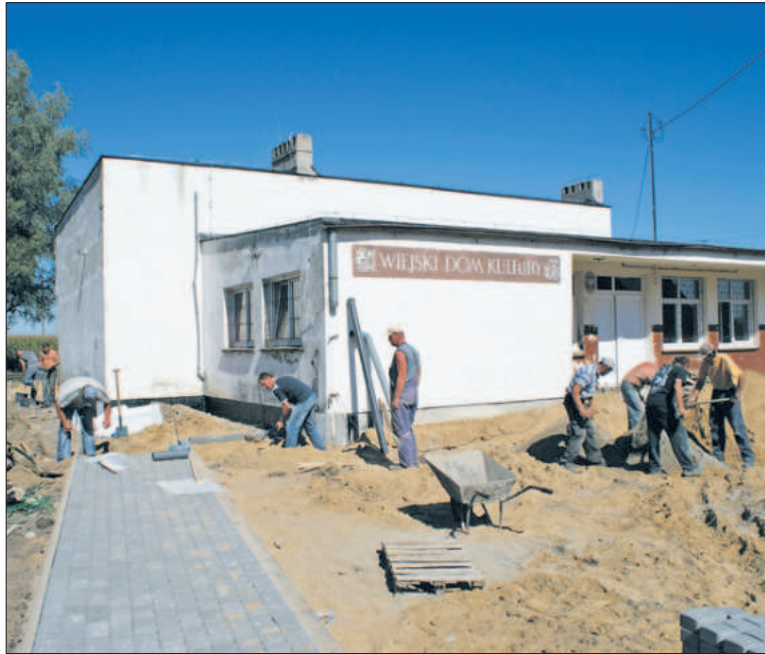
Trwa utwardzanie placu kostką brukową przez pracowników firmy „Kruk”
