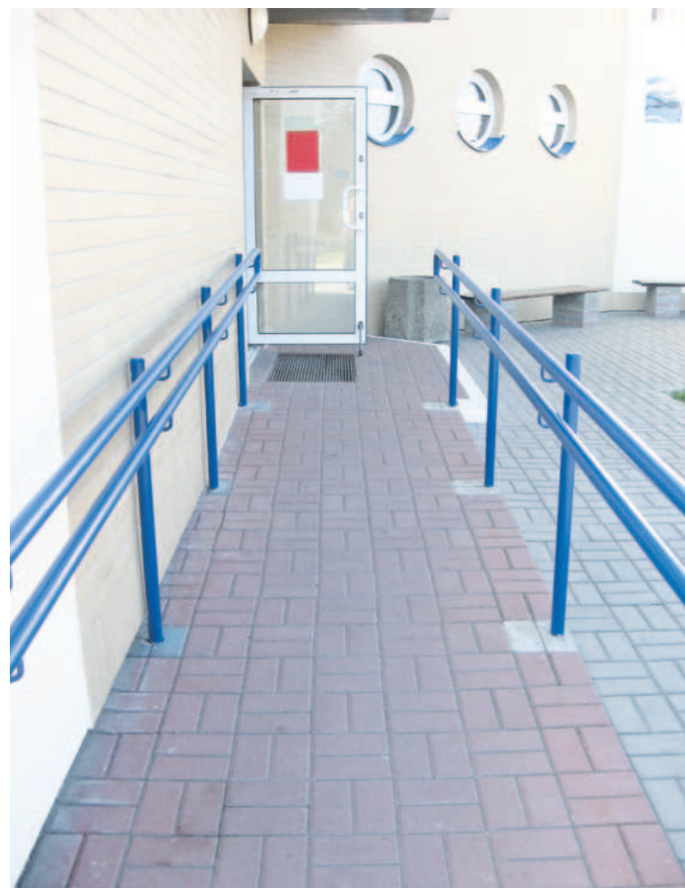
Wejście do Pływalni Miejskiej w Wąbrzeźnie
