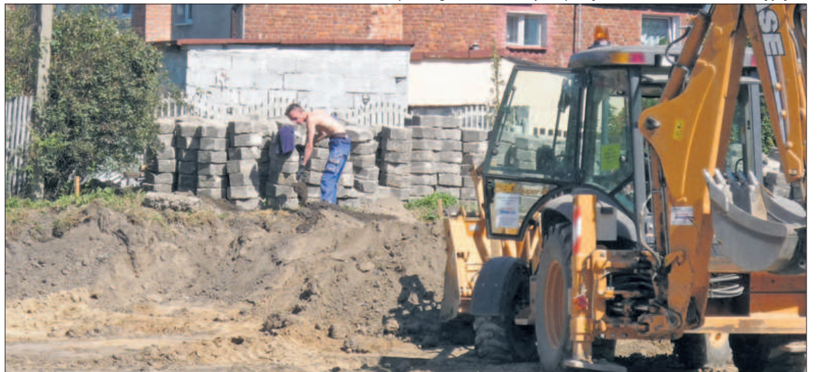
Prace nad budową parkingu mają być ukończone przed dniem Wszystkich Świętych
