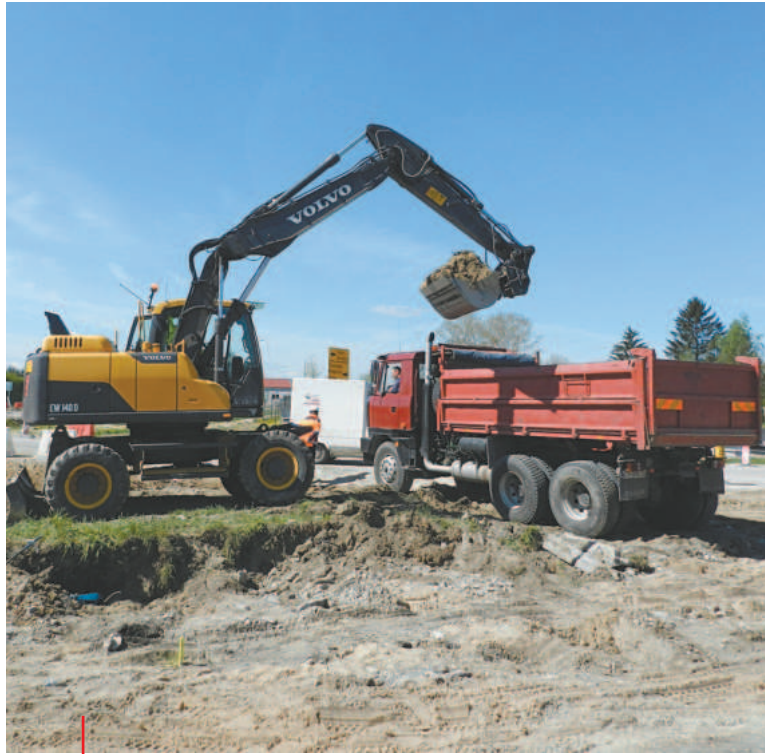
Na budowie ronda pracuje ciężki sprzęt
