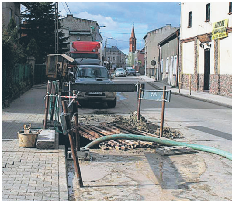
Modernizacja sieci wodociągowej
